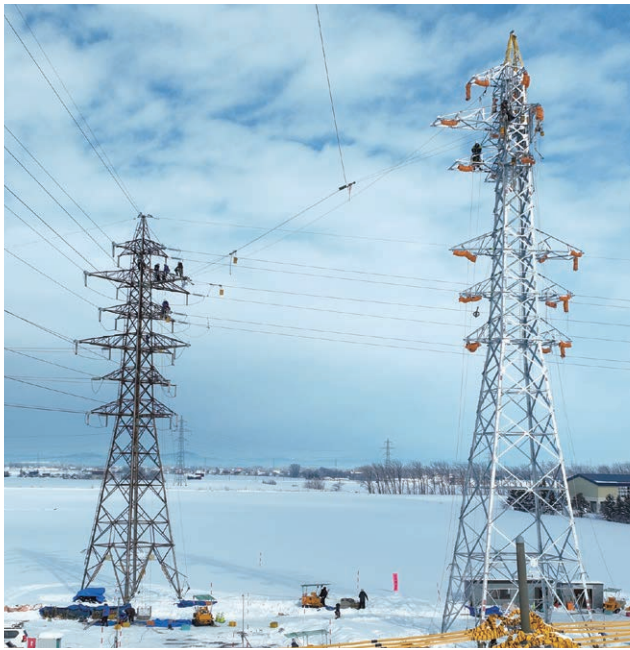
▲空知線(江)鉄塔建替(4期)(電線移線)
