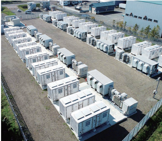
▲MC北広島蓄電所建設工事(蓄電池設備)
