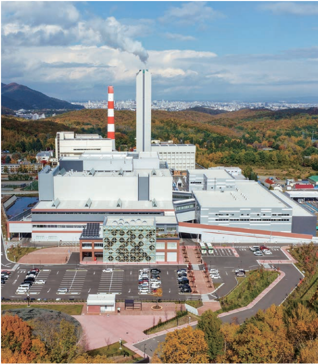
▲駒岡清掃工場更新事業建設工事(電気設備)
