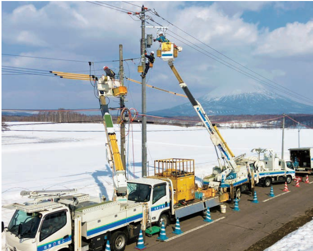
▲変圧器移設工事
