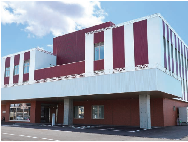
▲上富良野町立病院改築工事(電気設備)
